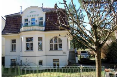
Blick von der Strandpromenade auf das Haus.
