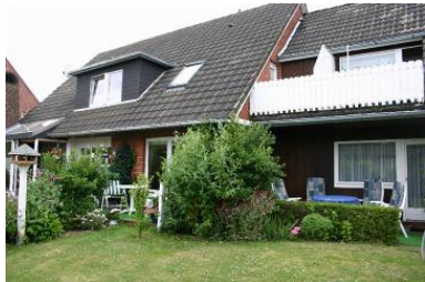
Das Haus "Pidder Lyng" mit Sonnenterrasse und insgesamt 5 Wohneinheiten.
