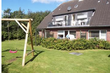
Gartenansicht Haus Severin in Goting
