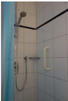
Die Dusche mit Haltegriff.
